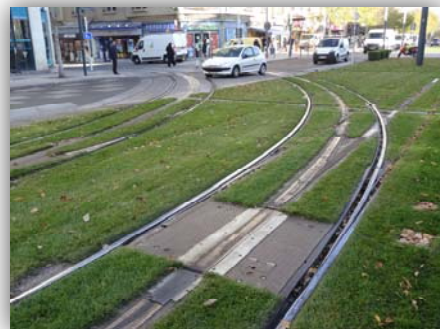
Mitt i en av Angers bredaste avenyer har grässpår fått ta över efter den asfalt som låg här innan. Här har även staden valt strömförsörjning via marken istället för via luftledning.
